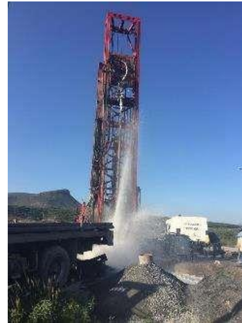
Perforación de pozos de agua con profundidad de hasta 500 metros con diámetro de hasta 22 pulgadas.
