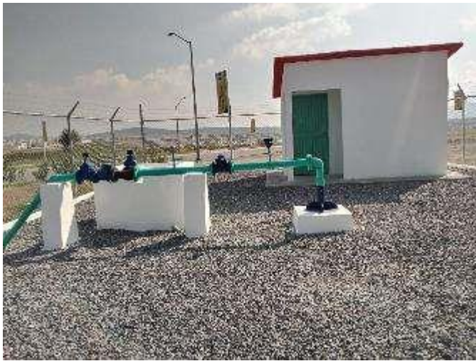
Construcción y equipamiento de caseta de controles para el funcionamiento del pozo de agua.
