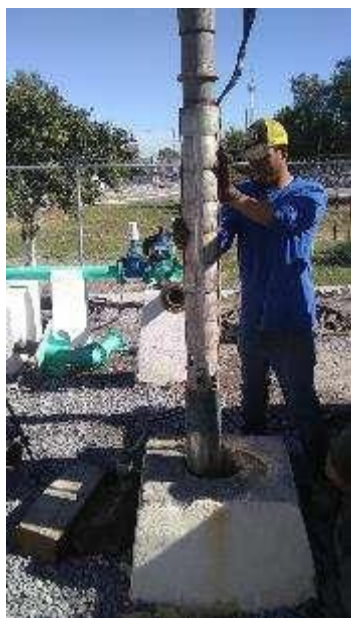
Abastecimiento y reemplazo de tubería de columna de impulsión.
