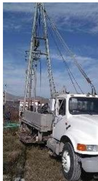
Maniobras de instalación y desinstalación de equipo de bombeo.
