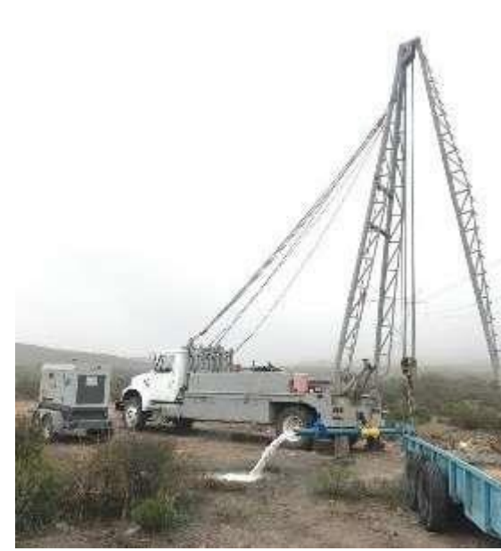
Aforos de pozos de agua.
