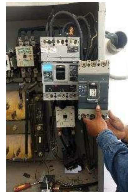
Mantenimientos eléctricos a arrancadores.
