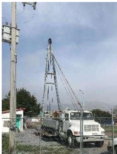
Maniobras de instalación y desinstalación de equipo de bombeo.
