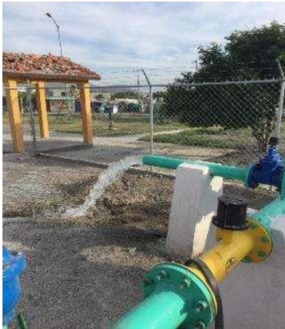
Equipamiento del pozo de agua (tren de descarga, columna de impulsión, bombas, motores, etc).
