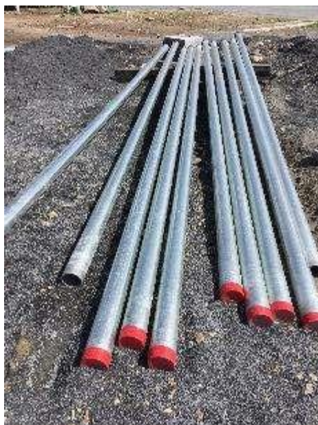
Abastecimiento y reemplazo de tubería de columna de impulsión.
